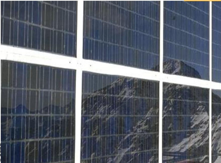
Photovoltaik-Fassade auf dem Rothorn
