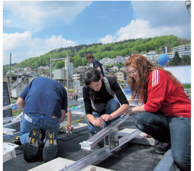
Installieren einer Solaranlage auf dem Schulhaus Planen Sie in einer Projektwoche eine Solaranlage auf dem eigenen Schulhaus.
